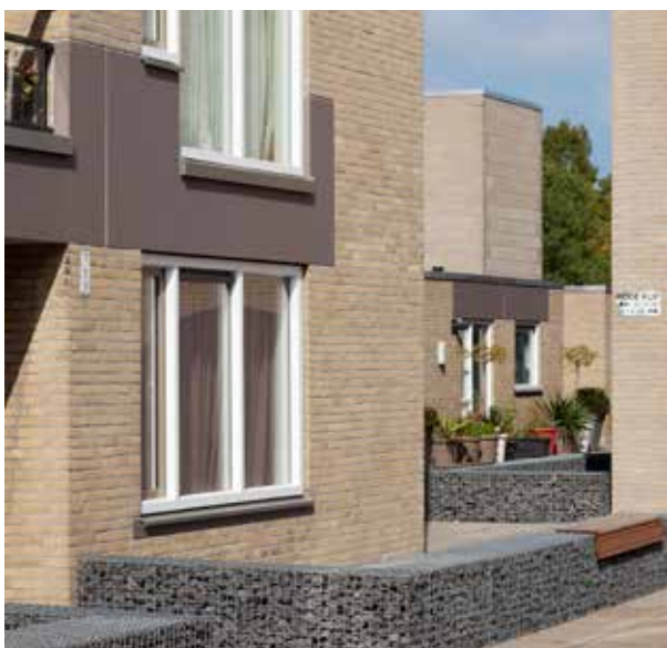
Het Rode Klif na de renovatie
