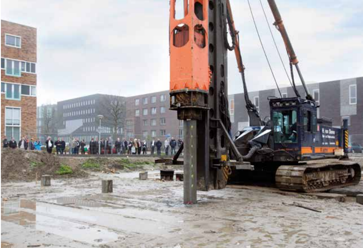
Start bouw van de elf stadswoningen in HanzePark.
